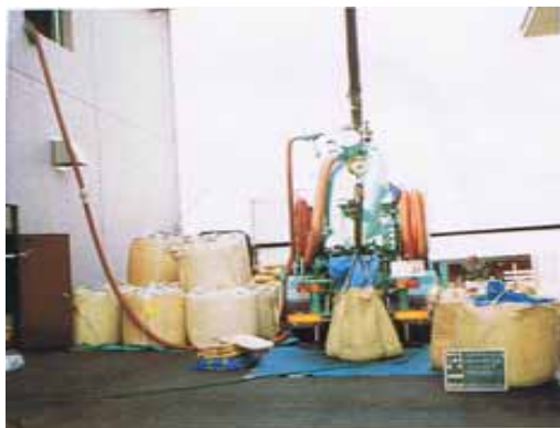
活性炭充填・取り出し工事
